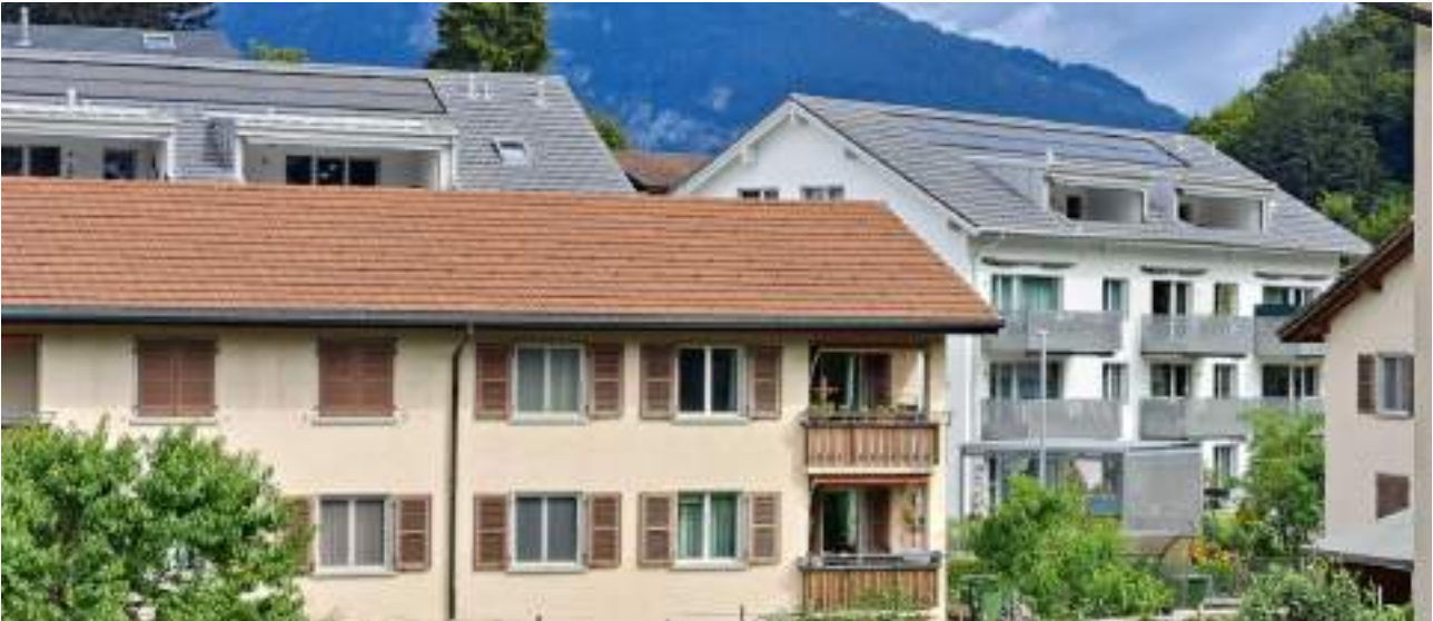
Quelle: Neubau Genossenschaftswohnungen - CNAG
